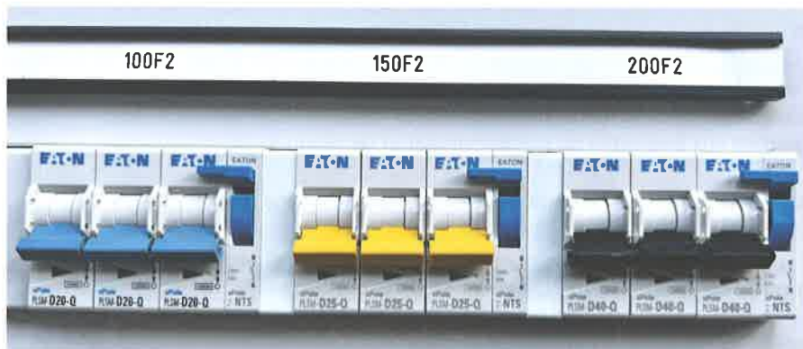
4.6.2 Figure 2: Disjoncteurs de canalisation bipolaires utilisés comme un coupe-surintensité d'abonné
