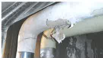
Mortier dans les canalisations
